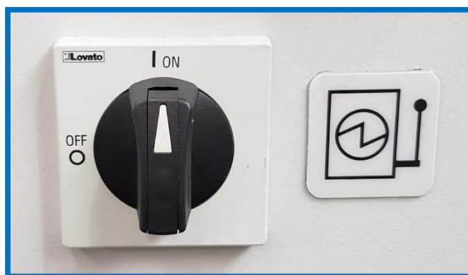
Ruotare in posizione ON il sezionatore generale presente sul quadro elettrico. Attendere fino al completo avvio del pannello utente. Sullo schermo apparirà una barra orizzontale che indica il tempo di attesa rimanente.
