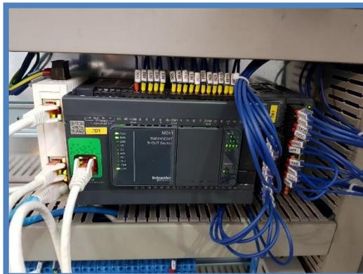
La parte logica del sistema è svolta da un **PLC M241** della Schneider. Oltre ad esso possono essere presenti le schede opzionali di espansione input / output.
